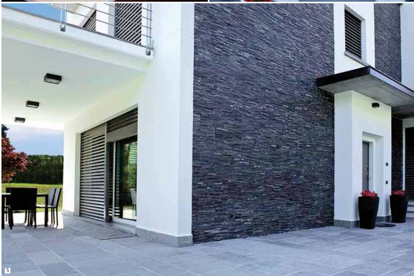
1. - 2. - 3. - 4. - 5. Esempi di realizzazione
